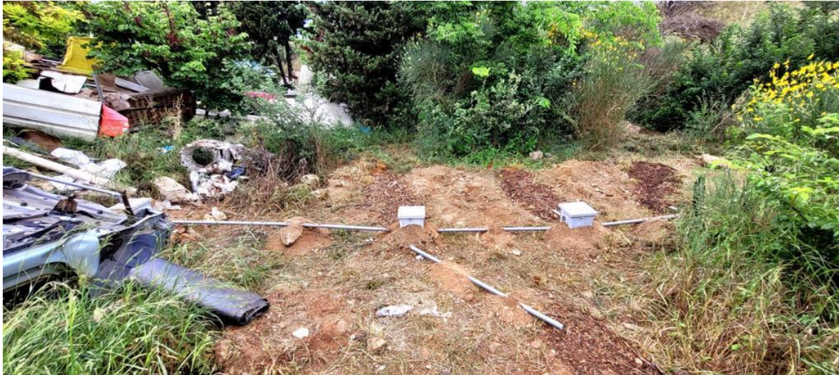
Figure 6 : Photo d'un filtre à broyat de bois installé sur un site à Marseille
