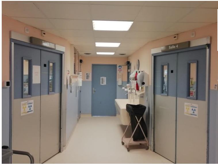
Vue extérieure salles d'interventions ortho
