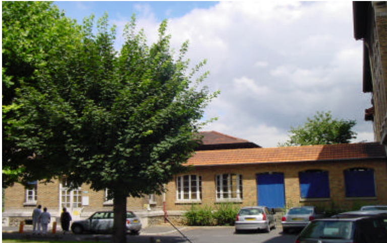
BATIMENT QUENTIN Façade avant
