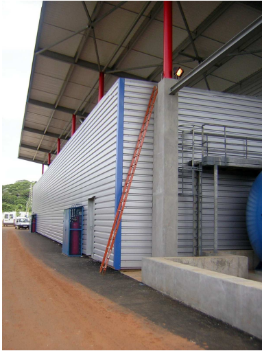
1. Accès au toit
