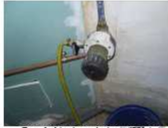
Figure 8 : Adoucisseur du réseau d'ECS de l'Orangerie dont le suivi et l'entretien ne sont pas consignés dans un document
