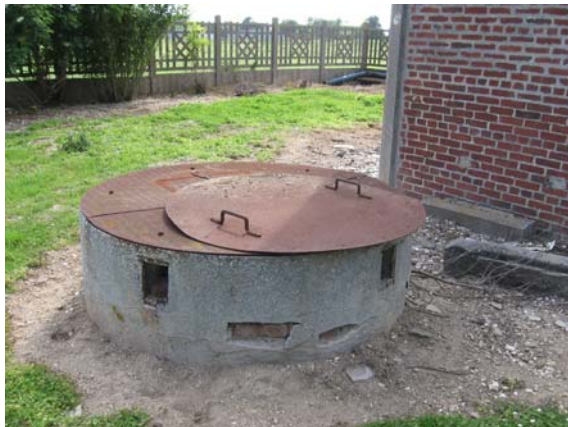
Figure 7 : exemple de captage abandonné très vulnérable
