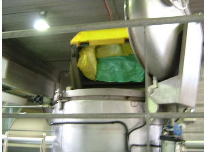
Une fois le couvercle ouvert, les GRV de DASRI sont chargés dans le banaliseur
