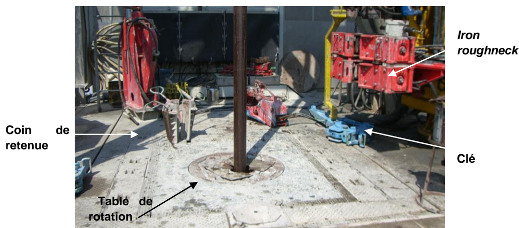
Figure 8 : Photographie du plancher d'un site de forage à terre (appareil ITAG, région parisienne)
