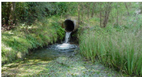
Figure 4 : Rejets d'eaux d'exhaure traitées provenant des sites de Margnac et de Pény, Haute-Vienne
