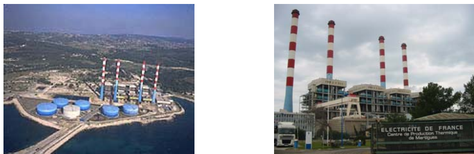
Figure 19 : Vue aérienne et photographie du CPT de Martigues-Ponteau.
