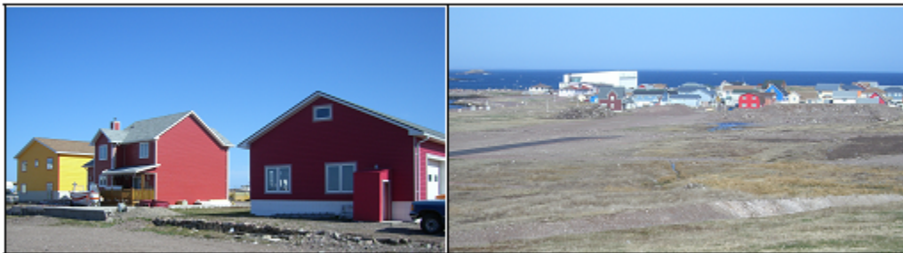
Désolidarisation des maisons et isolement du quartier des Graves [clichés : DE]
