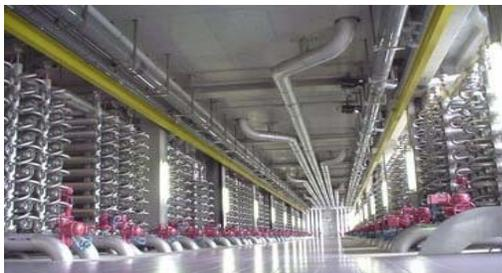
La nanofiltration (figure 3) retient les ions divalents et remplace les étapes d'ozonation et de filtration CAG (Charbon Actif en Grain). On parle de nanofiltration pour des membranes qui ont un seuil de coupure en masse molaire proche de 200 daltons.
