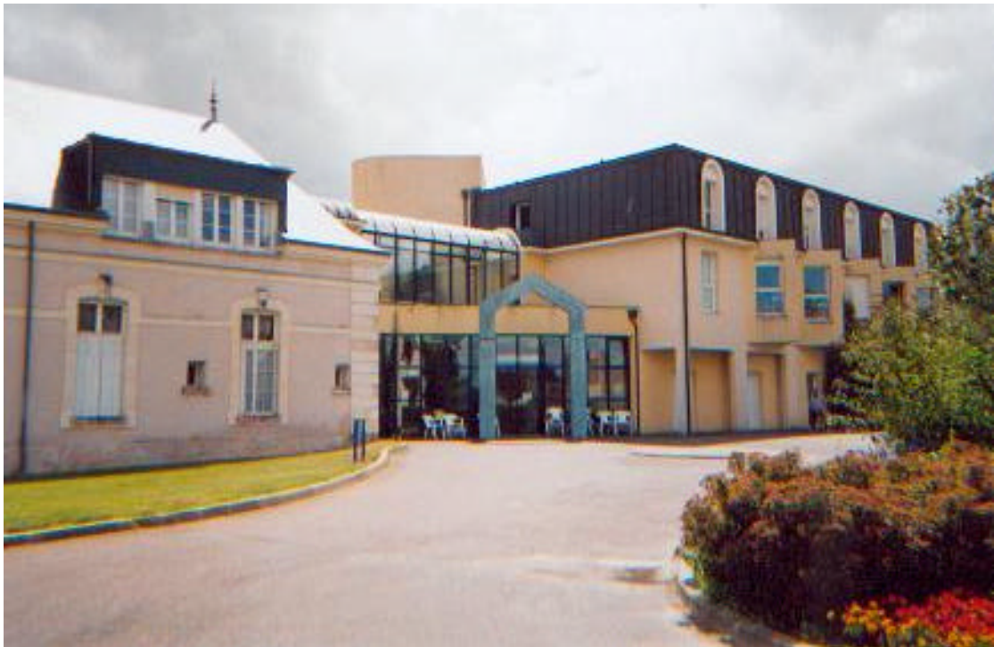
Entrée de L'Auverdière, partie hébergement
