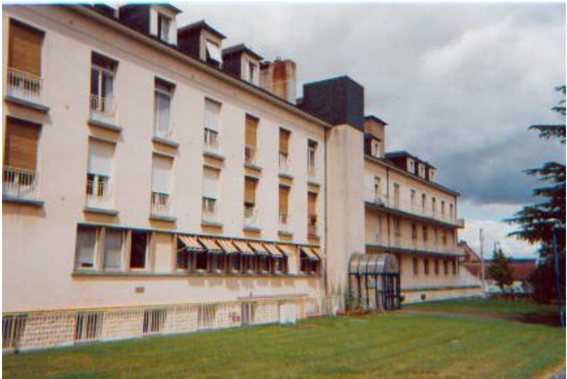
Le bâtiment de La Courtille, détail.
