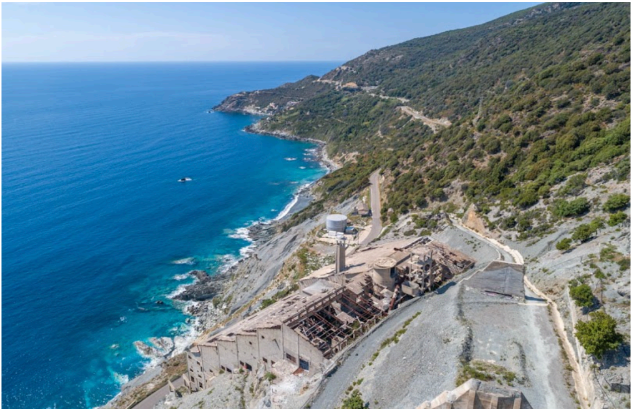
Vues du bâtiment de l'usine
