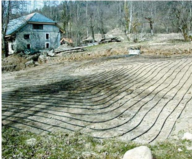
Figure 9 : Exemple de chantier de pose de sonde horizontale
