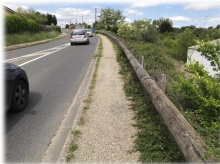
Exemple de la proximité des véhicules par rapport au trottoir
