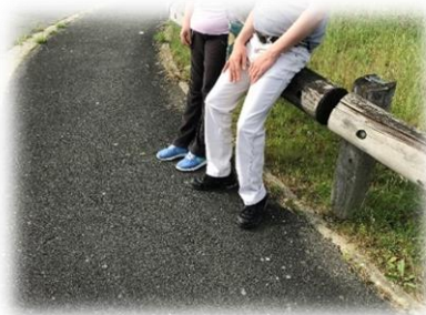
Exemple du manque d'aménagement d'espaces de repos sur le cheminement
