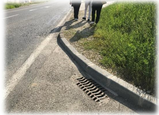
Exemple d'obstacle à l'accès aux trottoirs : absence de bateau facilitant l'accès au trottoir, plaque métallique sur le trottoir
