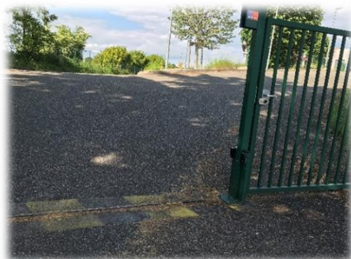
Exemple d'obstacle à la sortie de l'établissement : rail de portail surélevé
