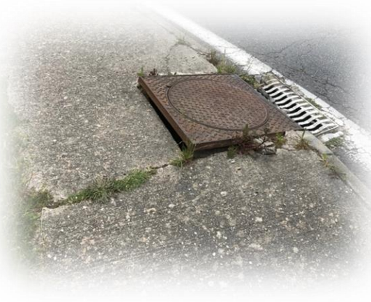
Exemple d'obstacle à l'accès aux trottoirs : absence de bateau facilitant l'accès au trottoir, plaque métallique sur le trottoir
