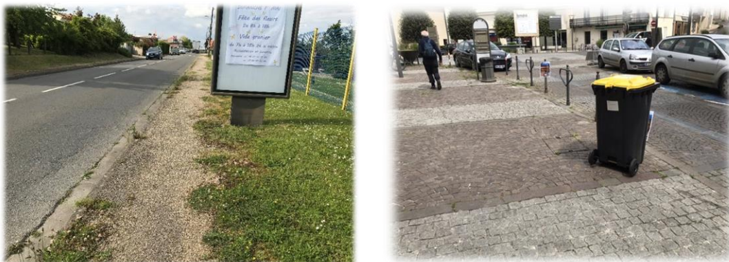
Exemple d'obstacle sur le trottoir et sur une place
