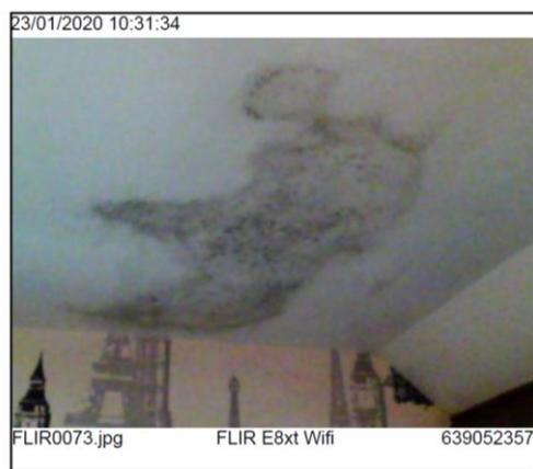
Grâce à l'image thermique, on constate que les zones les plus froides au plafond, en bleu, correspondent parfaitement aux zones de développement de moisissures sur l'image classique. L'image thermique met en évidence la présence d'un pont thermique.
