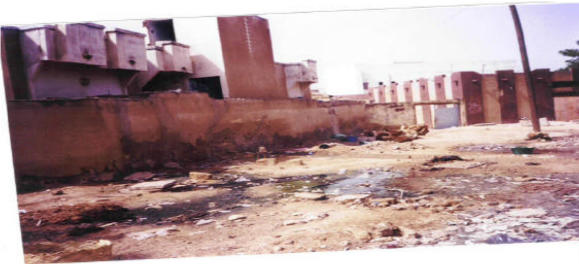
Photo n°3 : Le site de dépotage des camions de vidange de fosses septiques qui jouxte la décharge brute d'ordures n'a subi aucun aménagement pour éviter la contamination de la nappe.
