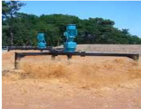
Photo A: Aérateur avec turbine
