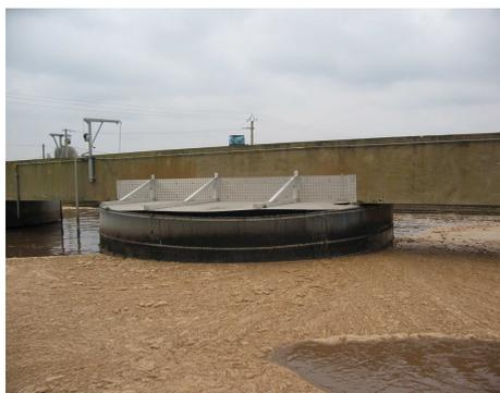
Photo B : Système de couverture à l'aide d'une jupe souple en tôle d'acier
