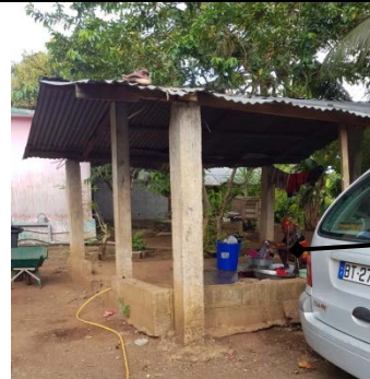
Figure 10. Lavoire construit dans le hameau à proximité de la prise d'eau
