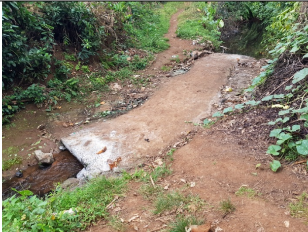
Figure 14. Passage à gué en béton
