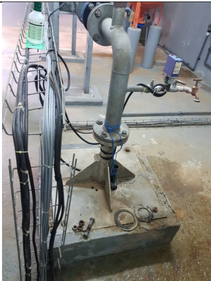
Figure 10. Forage de Méresse
