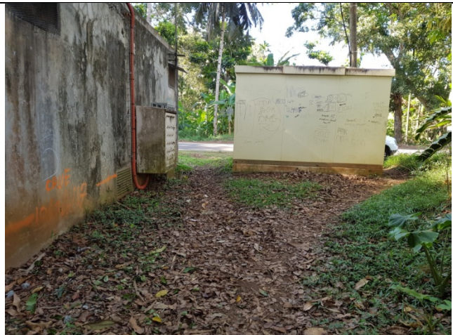
Figure 8. Accès PPI et marque de la crue de 2017
