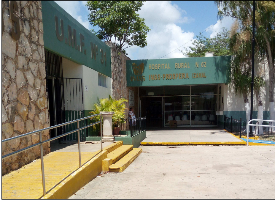
Source : photo de l'hôpital d'Izamal (Annexe 2) prise par Marine Fernandez le 17/05/18
