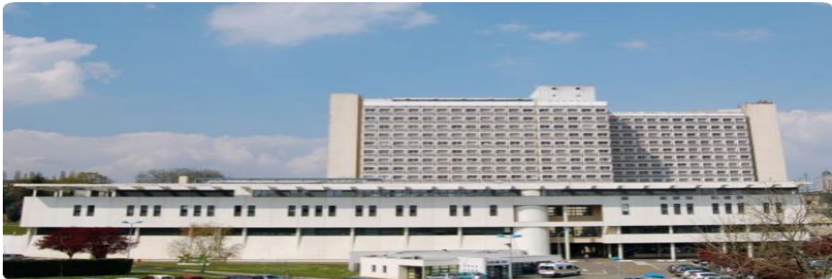
Centre Hospitalier de Laval
