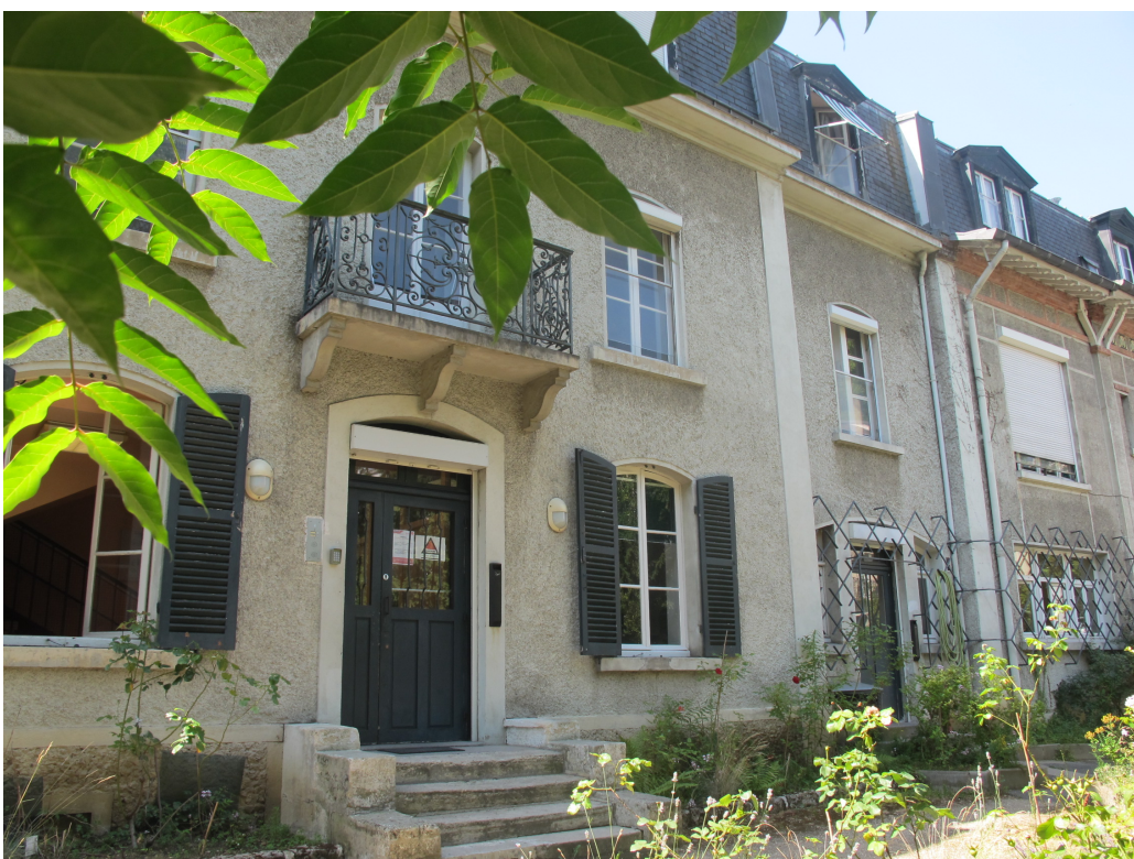
Façade du bâtiment en longueur
