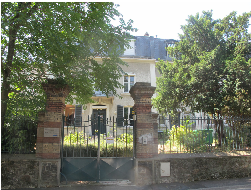
Façade du bâtiment depuis la rue
