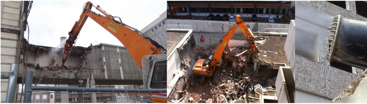
Figures 9 et 10 : Déconstruction par une pince à béton
