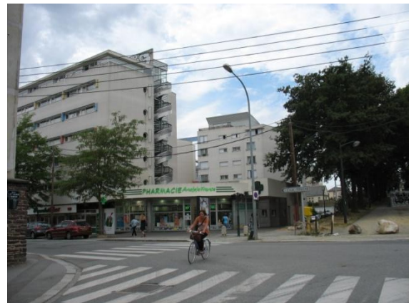
Boulevard de Verdun : Absence de voie cyclable, traversée de carrefour dangereuse pour les cyclistes venant de l'allée des Chênes, traversant en usant des passages piétons
