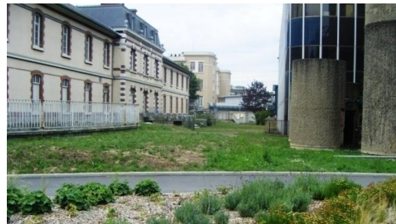
CHU : Toit du bâtiment des urgences et réanimation
