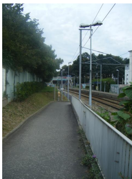
Halte ferroviaire : Le long de la voie ferrée côté CHU
