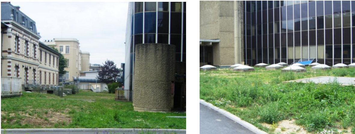
Figure 1 : Toit végétalisé du service des urgences et du Samu
