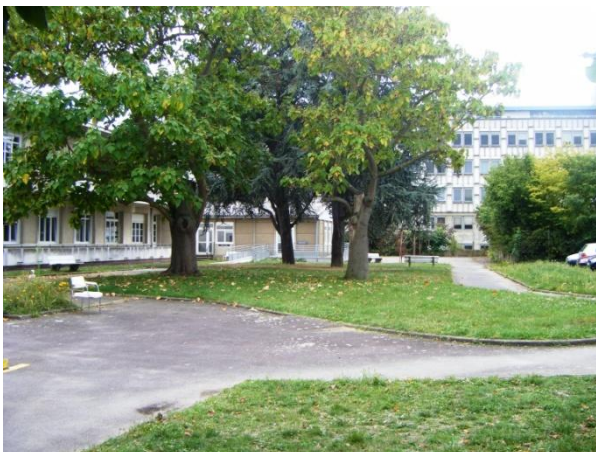
CHU : Entre le bâtiment de rééducation physique et fonctionnelle et le bâtiment de l'INSERM
