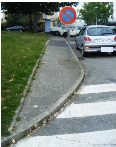
Site du CHU : Trottoirs non abaissés, absence de marquage podotactile, largeur de trottoir trop faible, stationnement sauvage de véhicule sur le trottoir
