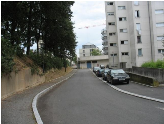
Rue Ricottier : Revêtement de trottoir inadapté et en mauvais état, stationnement sauvage de véhicules
