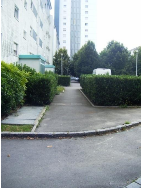
Rue Ricottier : Trottoir non abaissé
