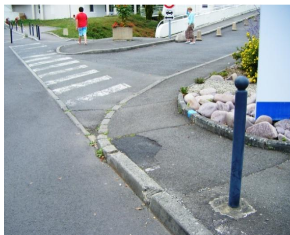
Site du CHU : Largeur de trottoir trop faible, chaussée déformée
