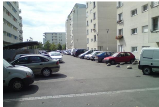
Rue Ricottier : Largeur de rue trop faible a première vue pour assurer la sécurité des piétons lors des manœuvres (demi-tour) d'enlèvement des ordures ménagères, chaussée en mauvais état
