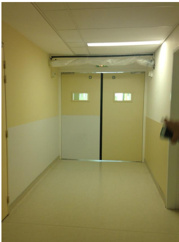
Séparateur amovible des zones à risque et des zones saines du service des maladies infectieuses et tropicales de l'HIA Bégin
