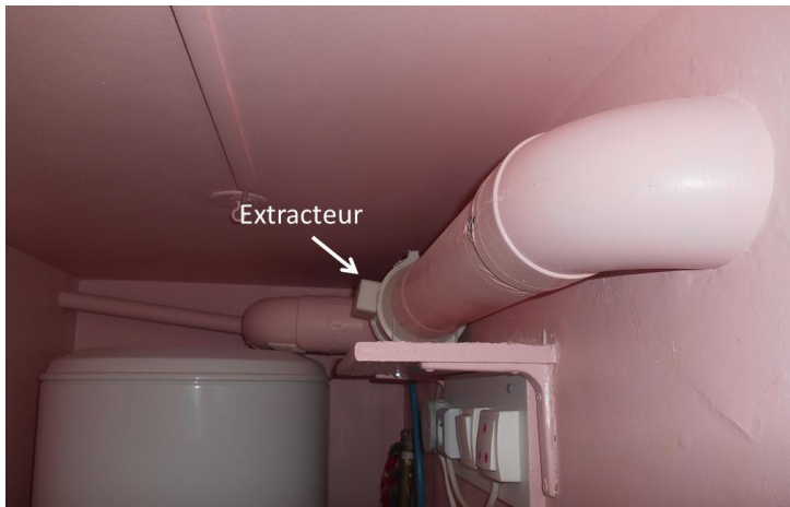
Mauvaise pratique : l'extracteur aurait dû être placé à l'extérieur de la maison ©RBBD
