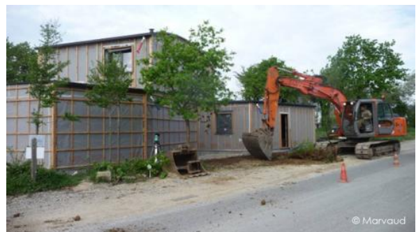
Pose du récupérateur d'eau de pluie
