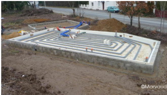
Il réchauffe la dalle en circulant dans un réseau de tuyaux
