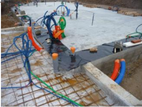
Pose de la membrane au niveau des murs et cloisons. Photo : B.Marvaud ©
