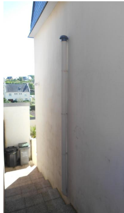
Bonne pratique : cheminée d'évacuation correctement installée ©RBBD
