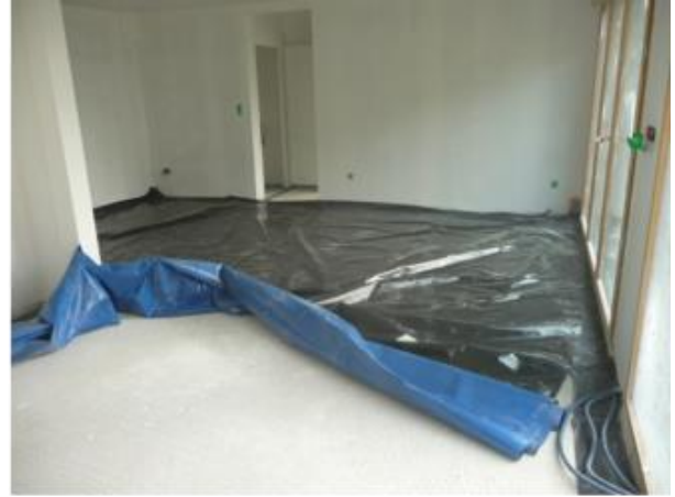
Pose du reste de la membrane. Photo : B.Marvaud ©
