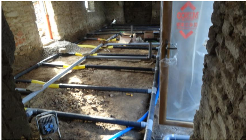
Installation d'un hérisson ventilé en rénovation ©Brélivet
