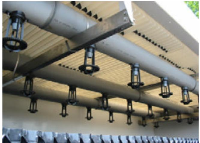
Figure 4: Rampes de dispersion et disperseurs
